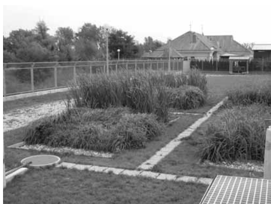
Slika 8. Pilot model biljnog pročišćivača Hrvatskih voda na lokaciji Hruščica
